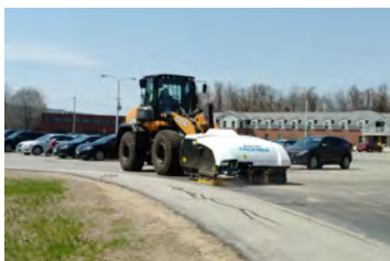
Balayage des routes et des rues
